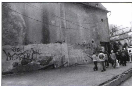
După zidurile de jos – traseul cetății
