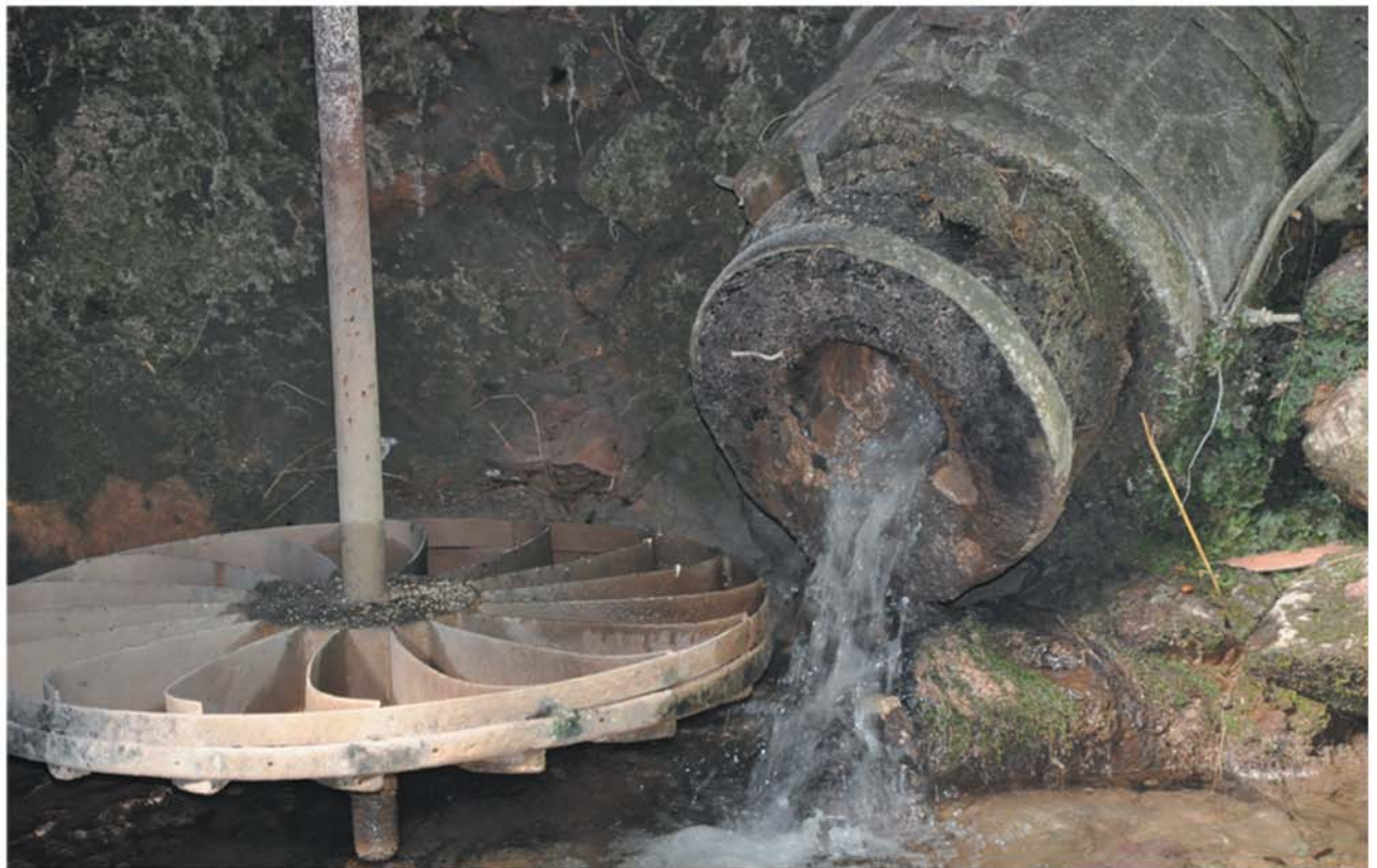
Fig. 61. Gârnici. Moara Berana
