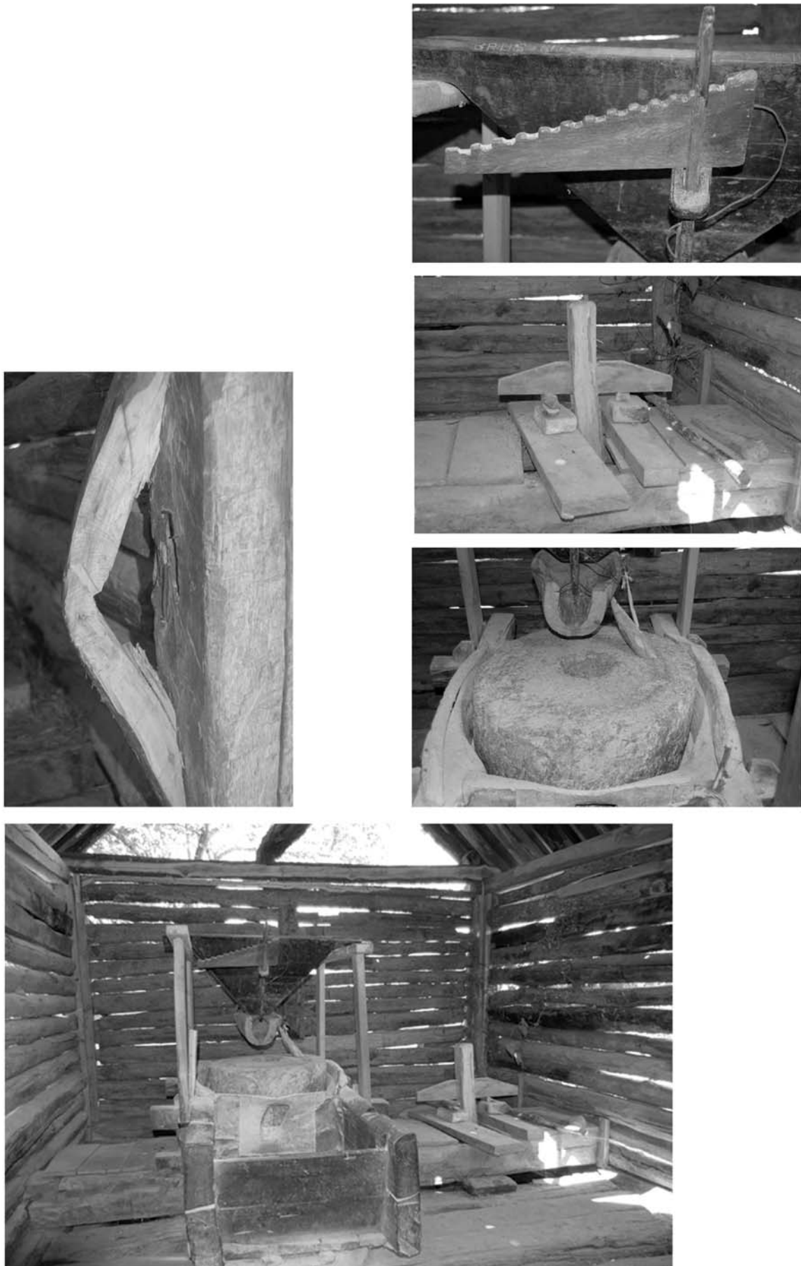
Fig. 135. Sichievița. Moara de la Stupă
