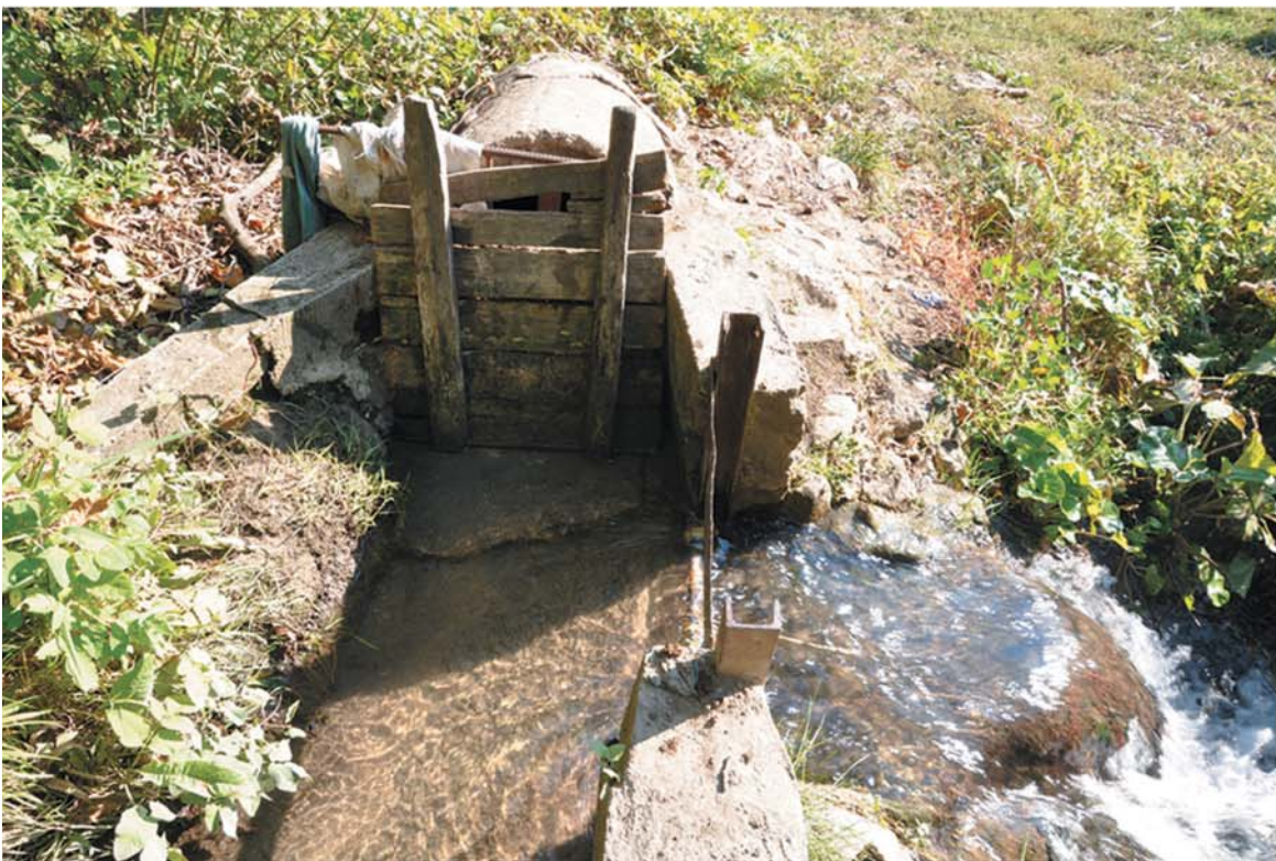
Fig. 73. Sichievița. Moara de la Stupă
