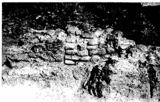
Fig. 6. Obreja – Satu Bătrân . a. Zidul sudic al navei bisericii și contrafortul; b-c. Detalii de la zidul de vest și nord al navei bisericii.
