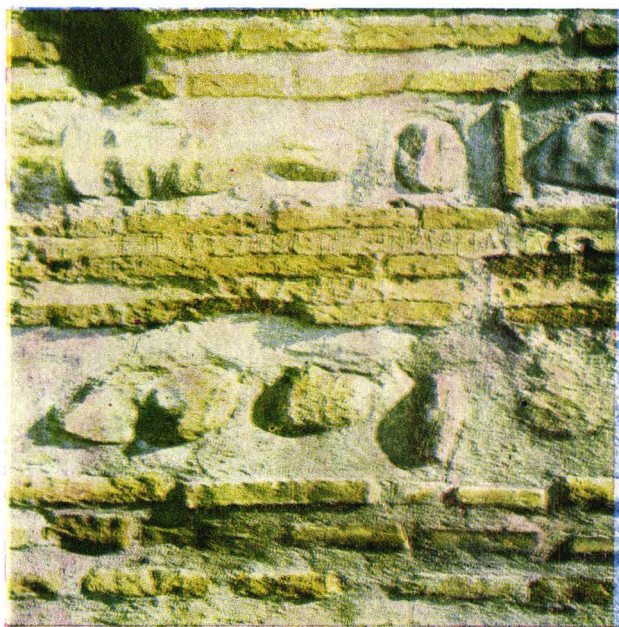
Fig. 10. Fașada sudică, detaliu (cu un grafit din faza de construcție).
