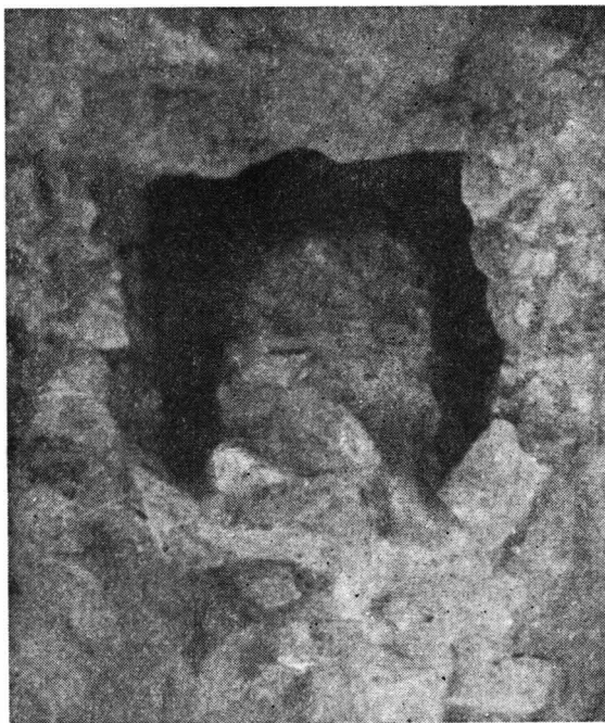
Fig. 22. — Urma unui tirant în zidul de nord-est al turnului nr. II.
