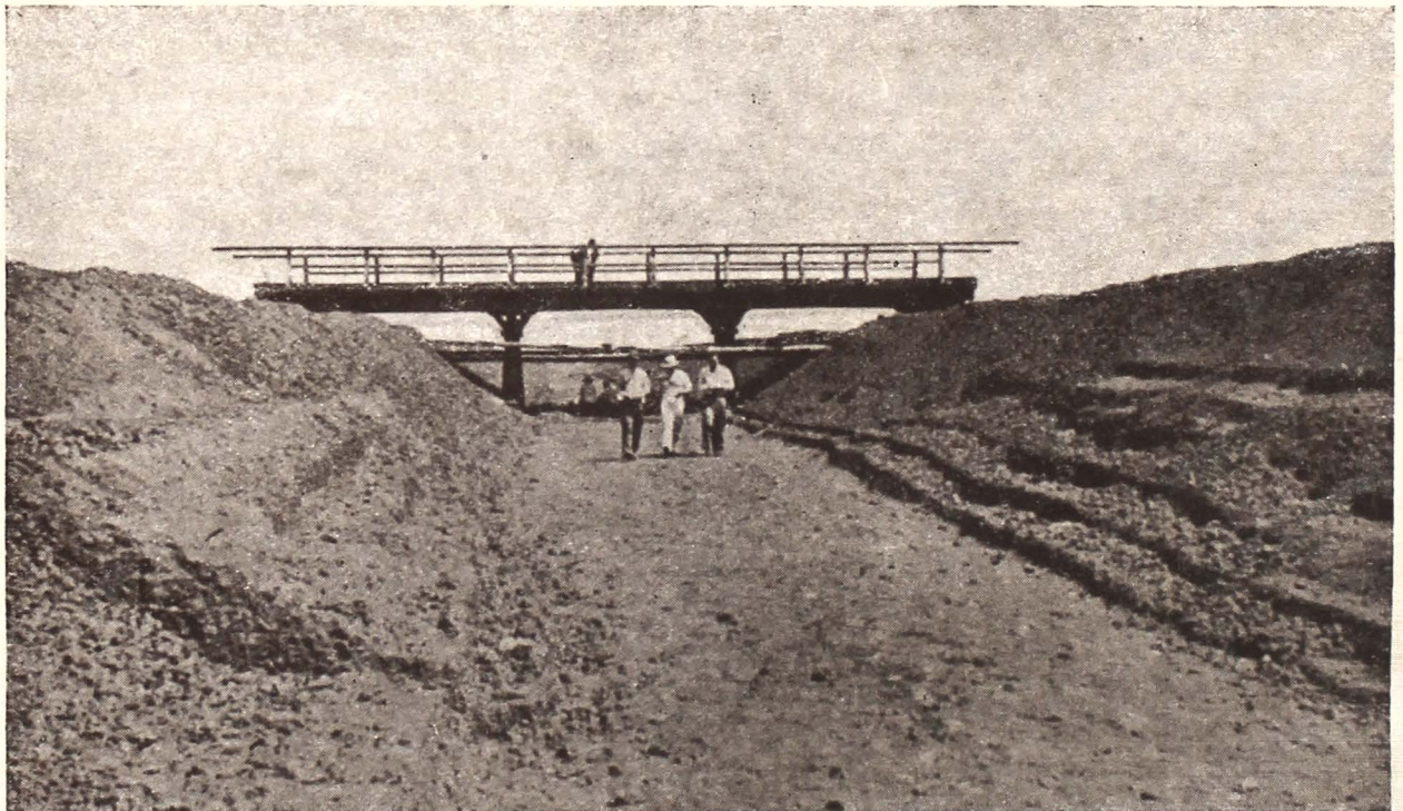
Fig. 73. — Vedere spre Valea Colentinei a canalului de derivație Bilciurești-Ghimpați.
