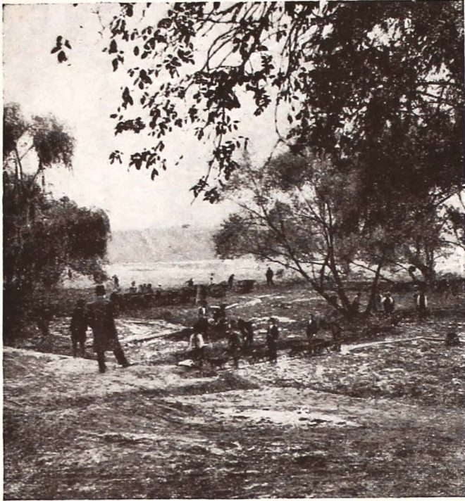
Fig. 30. — Lucrările de excavare a fundului viitorului lac Floreasca sunt dificile din cauza apei și nămolului.
