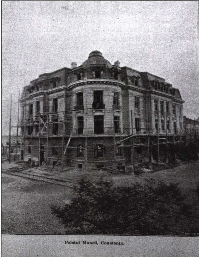
Palatul Muncii sau Palatul Corporației „Ovidiu” din Constanța. Lucrări de construcție.
