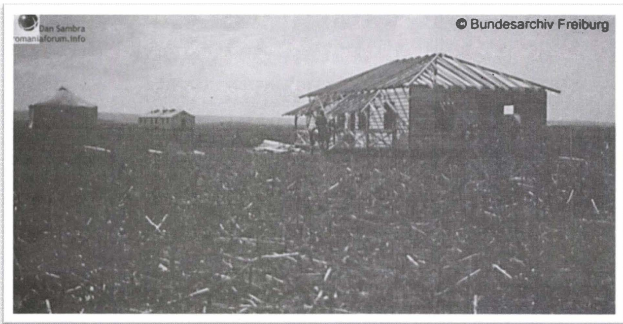
Hidroscală Duingi: Offiziershaus im Bau / Casa ofițerilor în construcție
