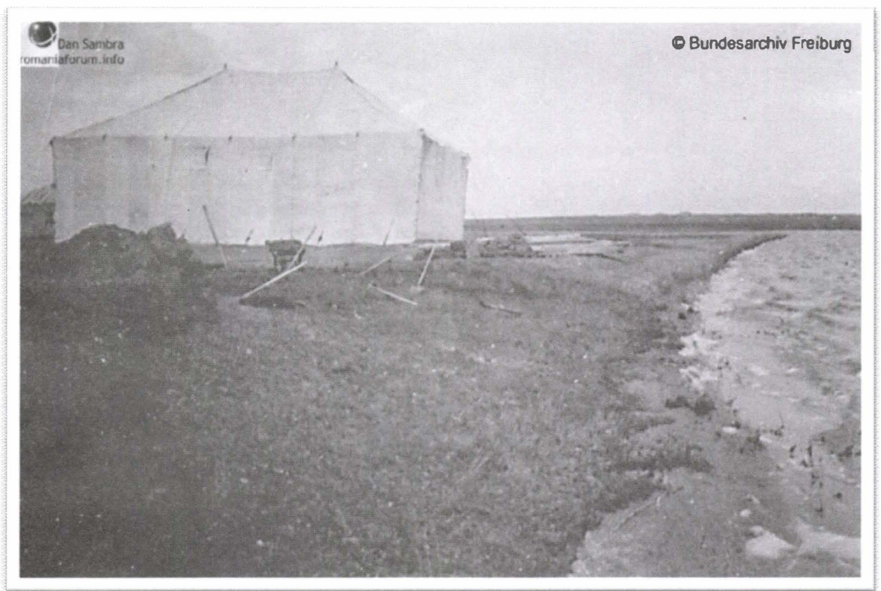
Imagini de la hidroskala Duingi (toate imaginile H_Duingi au dată 22 martie 1917): Ablaufbahn im Bau / Pistă pentru decolat, în construcție:
