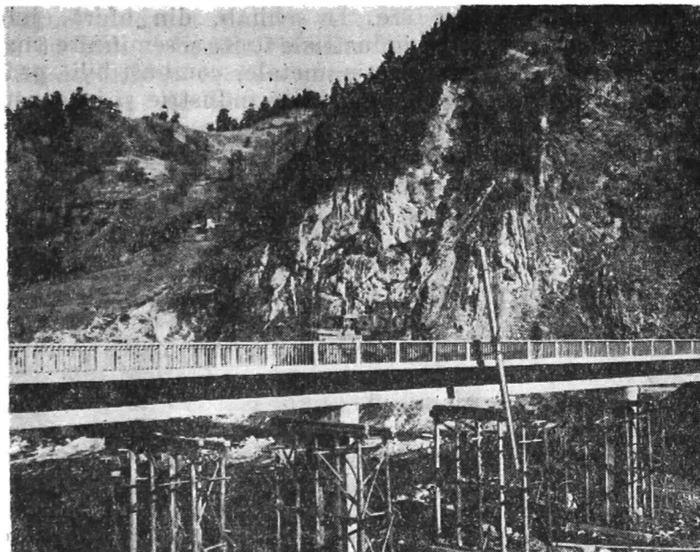
Fig. 42. — Pod în construcție peste valea Buzăului, la Nehoiăș (foto T. S t e r e).
