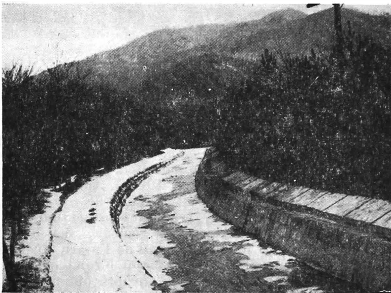
Fig. 7. — Amenajarea văii Cățiașu în vederea opririi alunecărilor de teren și a eroziunii solului.
