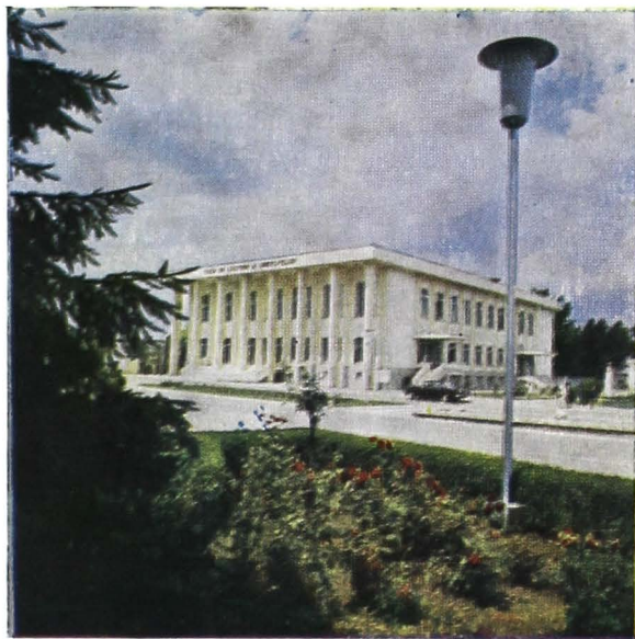
Fig. 28. — Casa de cultură a sindicatelor din Birlad (foto C.P.C.S.).
