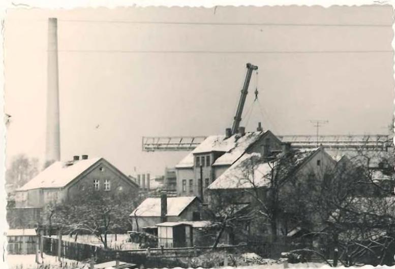
Das Auflegen der Trassenbrücke mittels Autokrahn über die FlockensträÙe in Neu- Oelsnitz.
