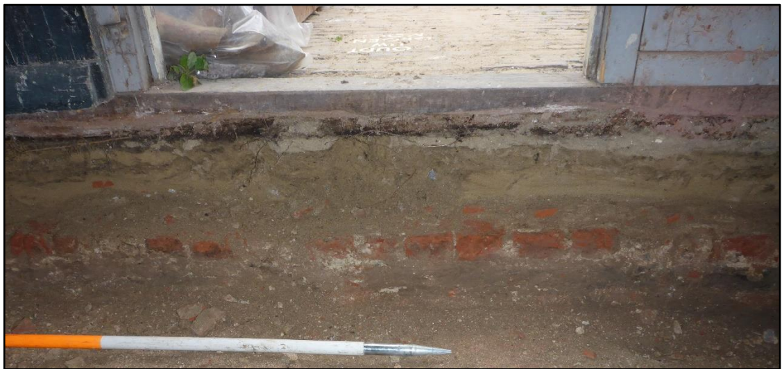
Figuur 30. Westelijke buitenmuur ter hoogte van de voormalige kaatsbaan. In deze figuur is te zien dat de muren van de kaatsbaan ter hoogte van werkput 1 zijn afgebroken, waarna een laag zand is aangebracht en sprake is van een nieuwere bouwfase van het muurwerk.
