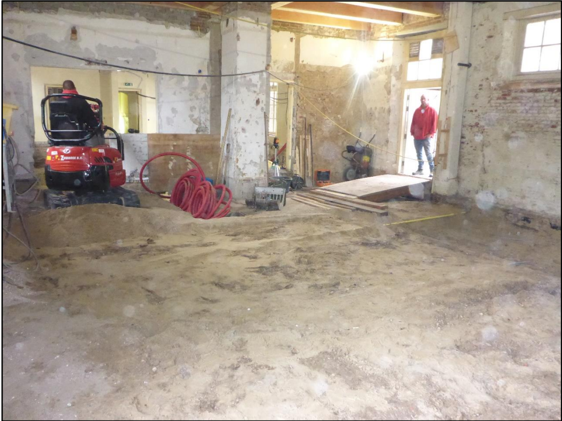
Figuur 6. Begin van de aanleg van het vlak in werkput 1.
