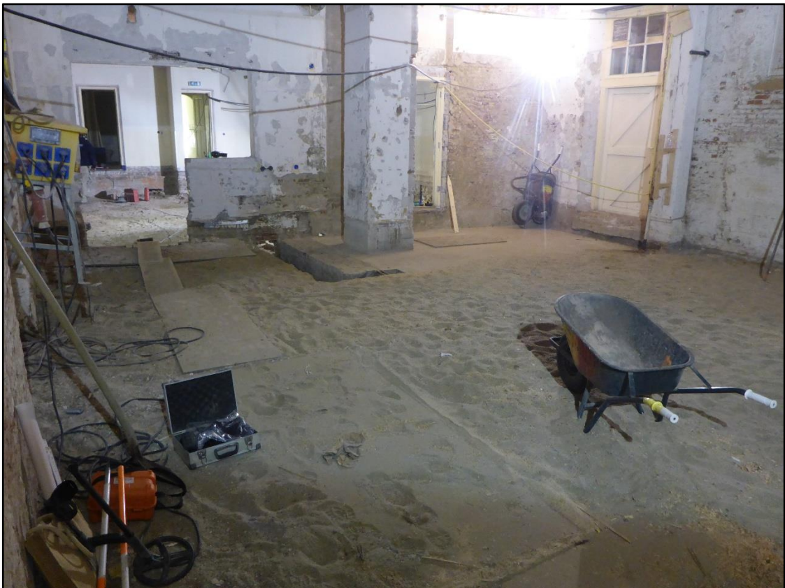
Figuur 4. Plangebied voor aanvang van de inpandige graafwerkzaamheden. De bakstenen vloer is reeds verwijderd.
