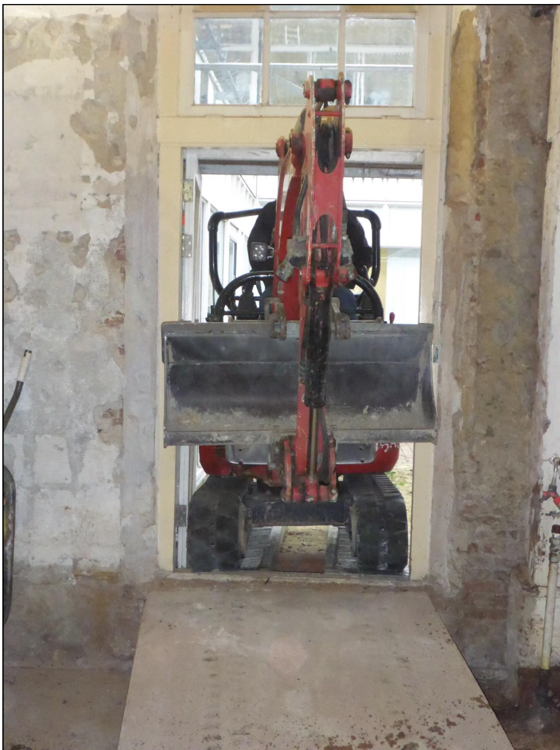
Figuur 5. De graafmachine past maar net door de deuropening heen.
