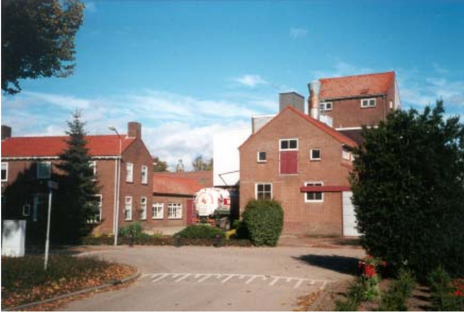
Afb. 6 De huidige situatie van het plangebied gezien vanuit het zuidwesten.
