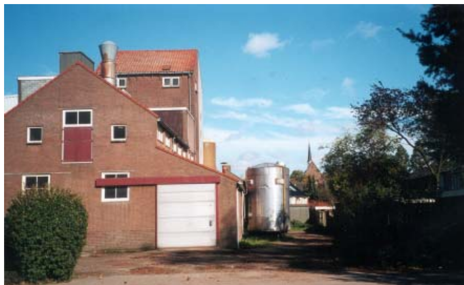
Afb. 5 De huidige situatie van het plangebied gezien vanuit het zuidwesten.
