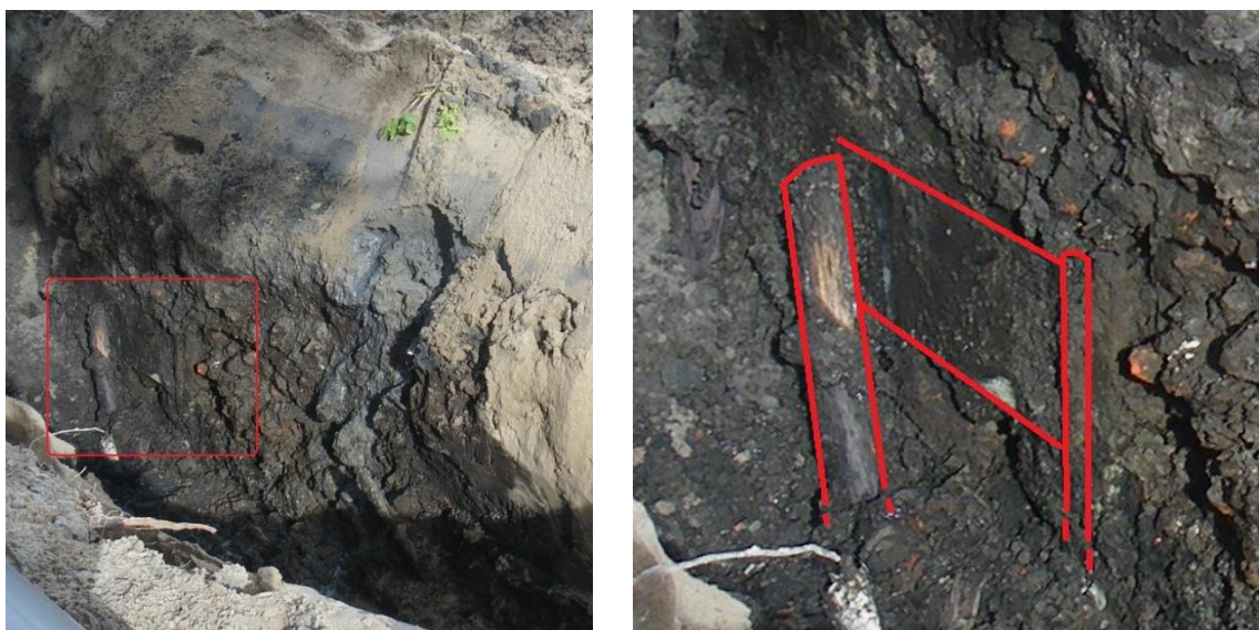
Afbeelding 7. Beschoeiing ten noorden van de kademuur. Links zoals aangetroffen in de rioolsleuf (rood kader), rechts in detail.
