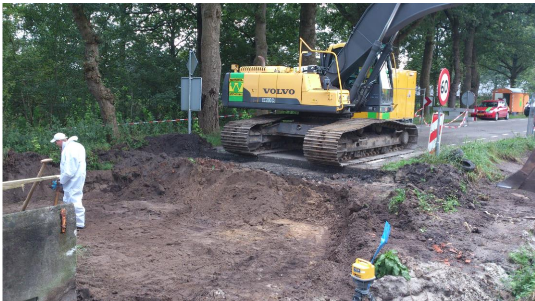
Figuur 5: Het vlak nadat de beide bakstenen wegdekken zijn verwijderd. De karrensporen laten zich niet goed onderscheiden.
