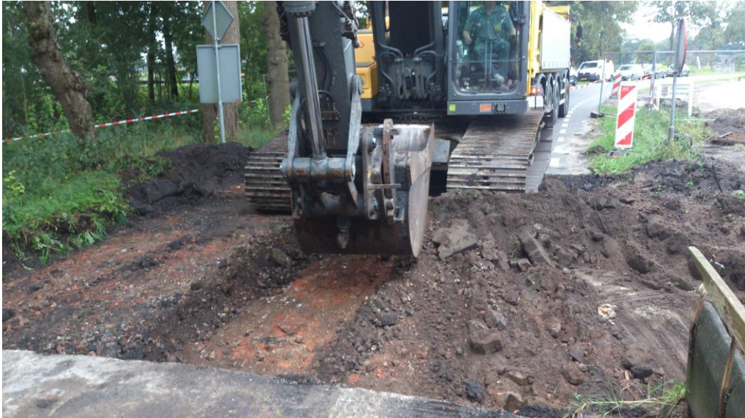
Figuur 4: Aanleg werkput 2, waarbij de bakstenen van oudere wegdekken zijn te zien.
