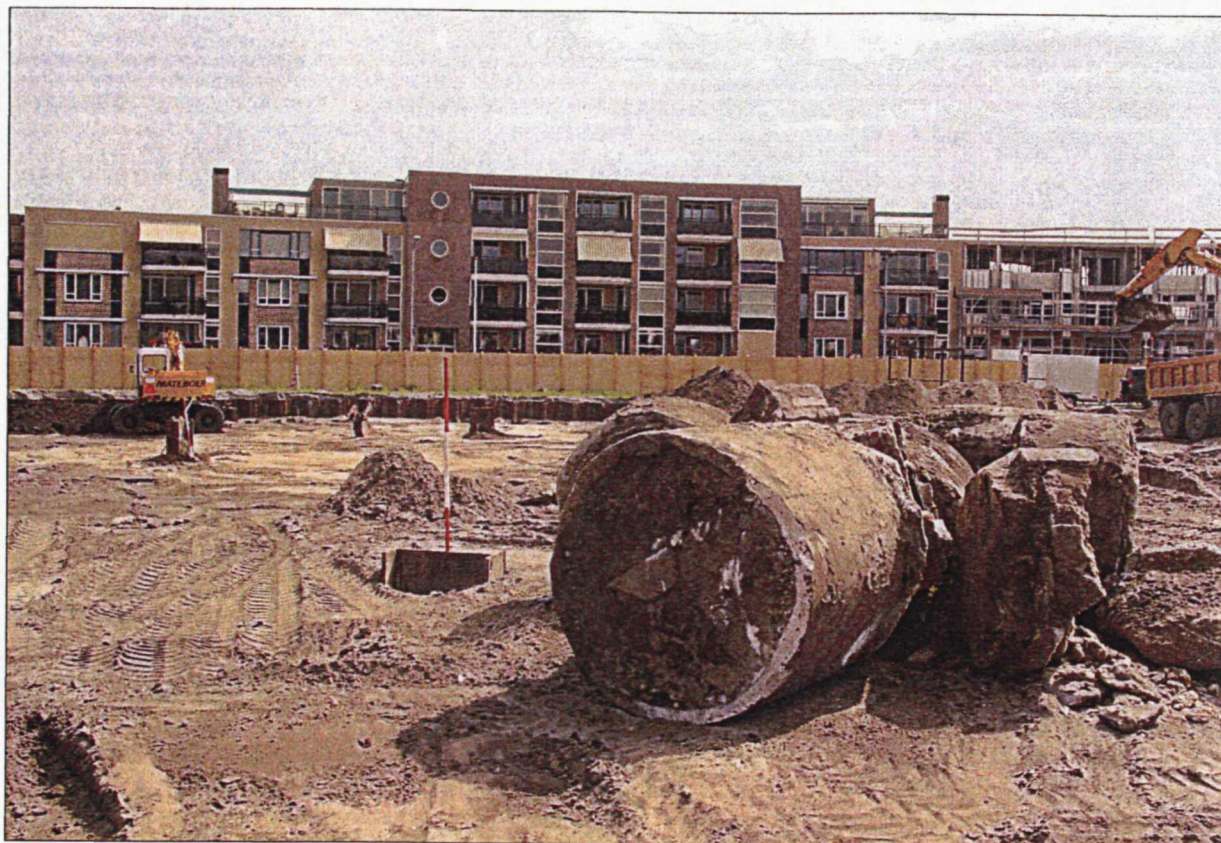
Figuur 3: Enkele grote betonkolommen.
