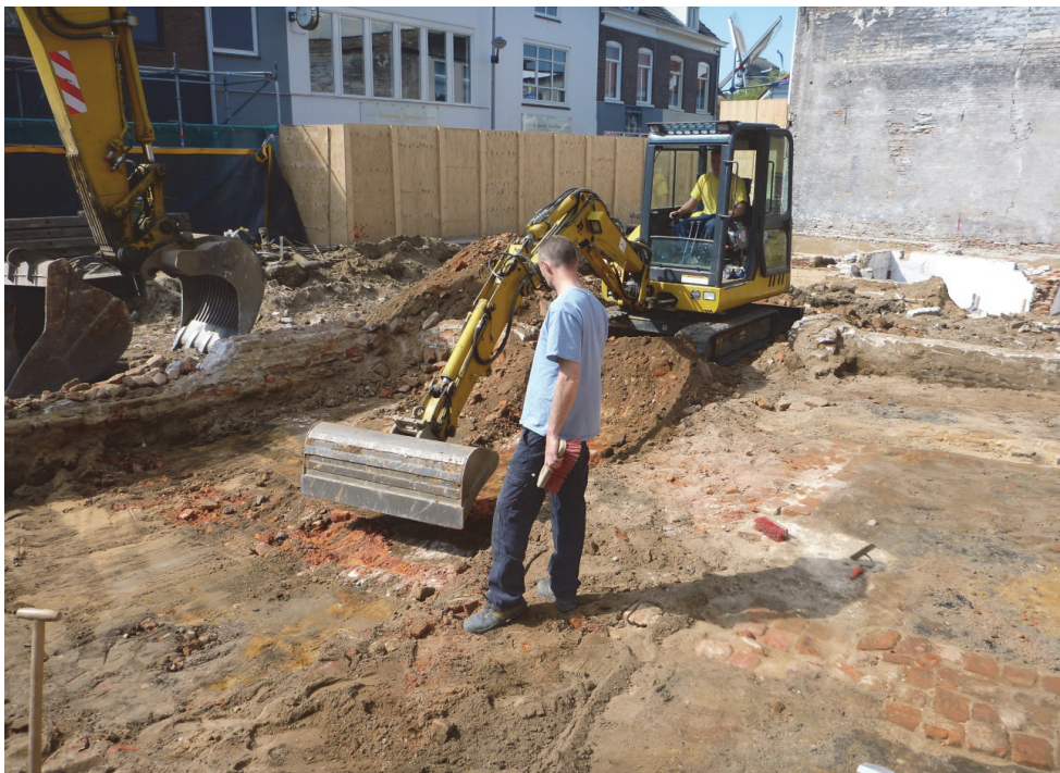
Fig. 4.1: De aanleg van het vlak.
