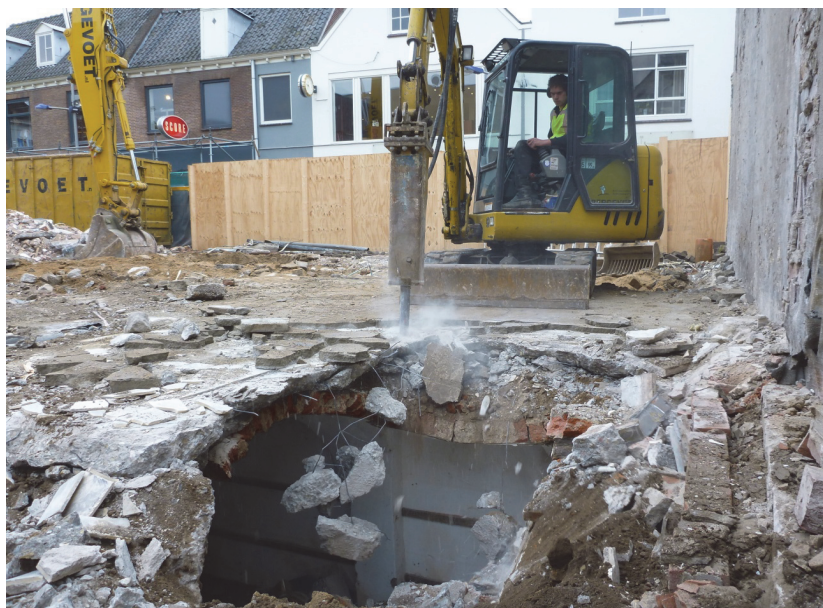
Fig. 5.7: Sloop van gewelf Kelder 1.
