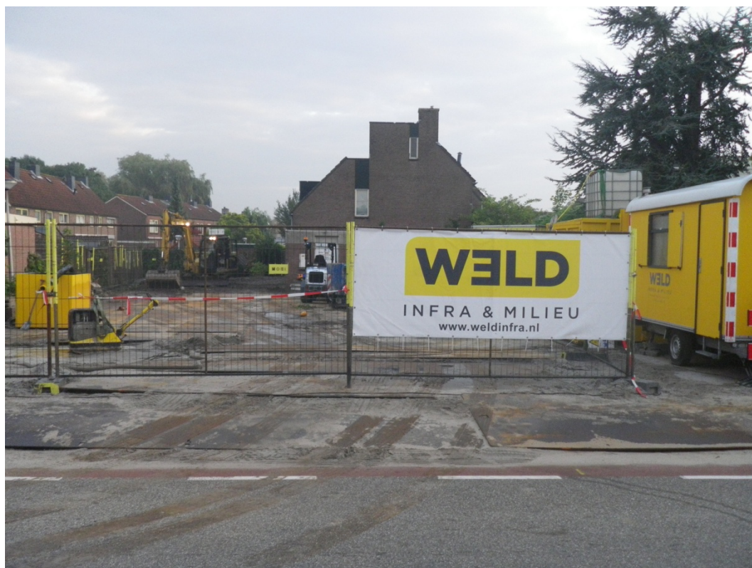
Afb. 2. Het plangebied voor aanvang van de sanering in deelgebied B.
