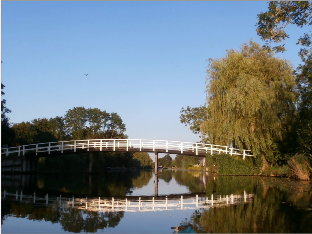
Afb. 4 Foto van de huidige brug (aangeleverd door Waterschap Rivierenland)
