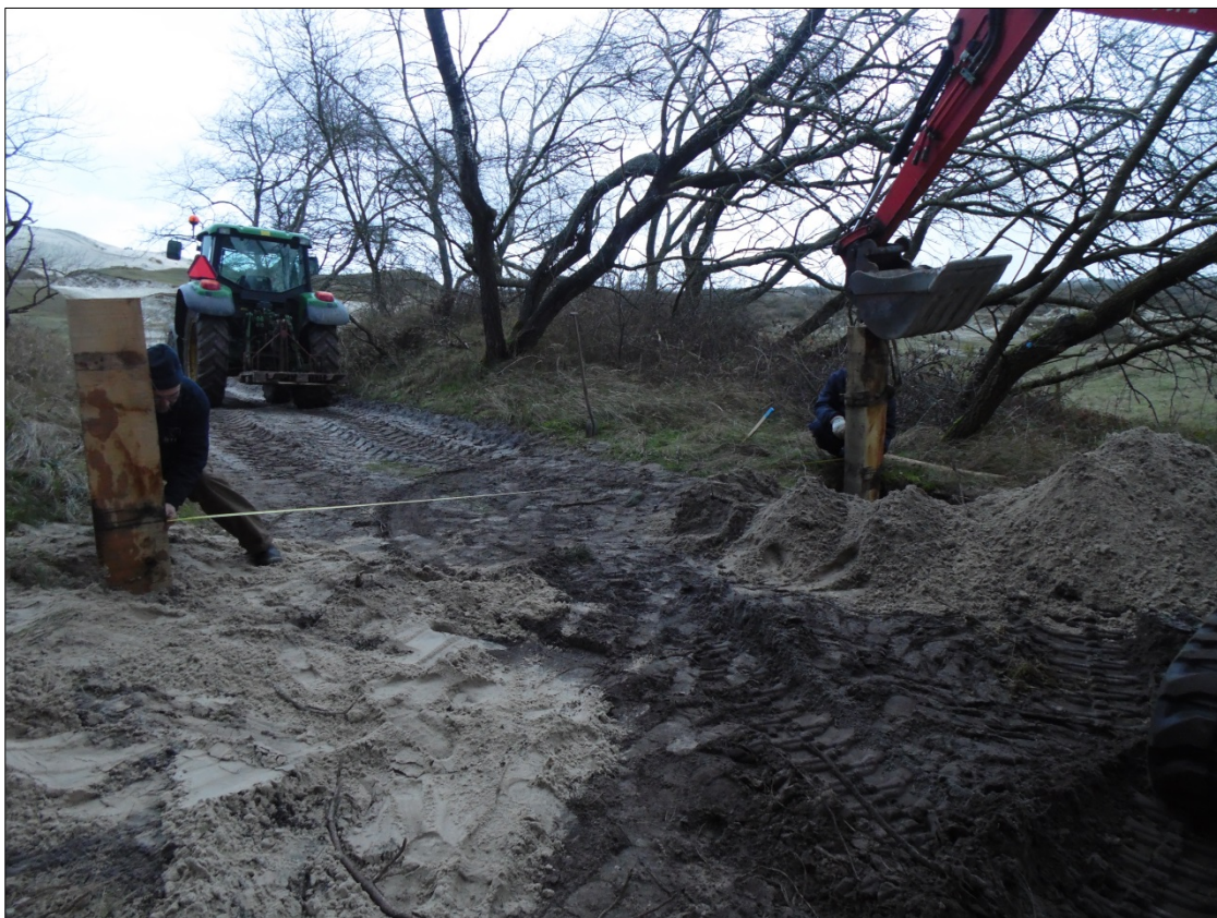
Afbeelding 11 en 12. Het aanbrengen van de bielzen voor het hekwerk.
