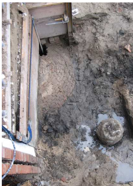
Afbeelding 29: Links, een gat in de overkluizing van de waterput S129 door het plaatsen van een bekistingspaal. Boven: voor de nieuwbouw geboorde paal door de bestrating van S121. Dit resulteert in een minimale verstoring van de klinkerbestrating.
