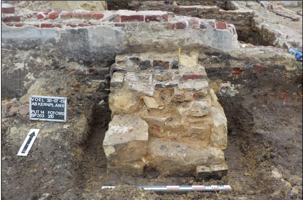
Afbeelding 106. Detailfoto van een mogelijke steunbeer (Spoor nr. 203 en 210). De foto (Foto nr. 101) is genomen vanuit zuidelijke richting.
