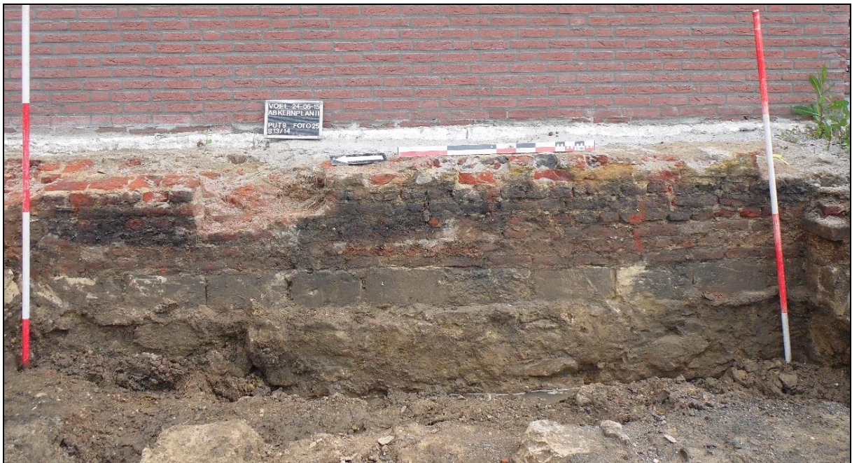
Afbeelding 46. Vlakfoto van de oostelijke buitenmuur (Spoor nr. 14 op 13). De foto (Foto nr. 26) is genomen vanuit westelijke richting. 19
