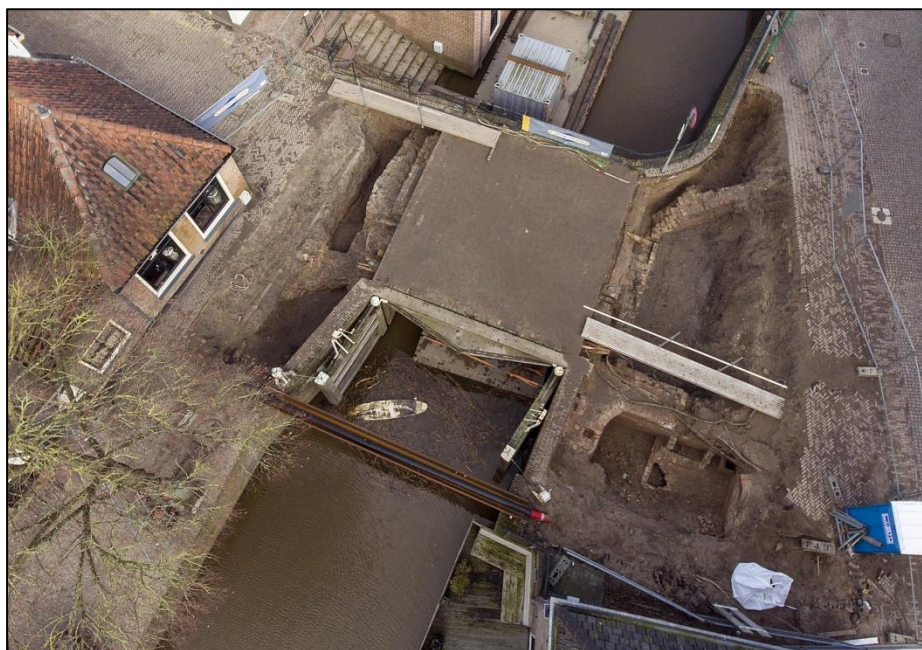
Figuur 2.12 Zicht op de Romeijnsbrug ten tijde van de begeleiding, waarbij de gewelven van de oude Ijsselpoort en de oude kademuren duidelijk zichtbaar zijn (foto: dhr. J. Harzing (Reclamebureau MZOEM) 2018).
