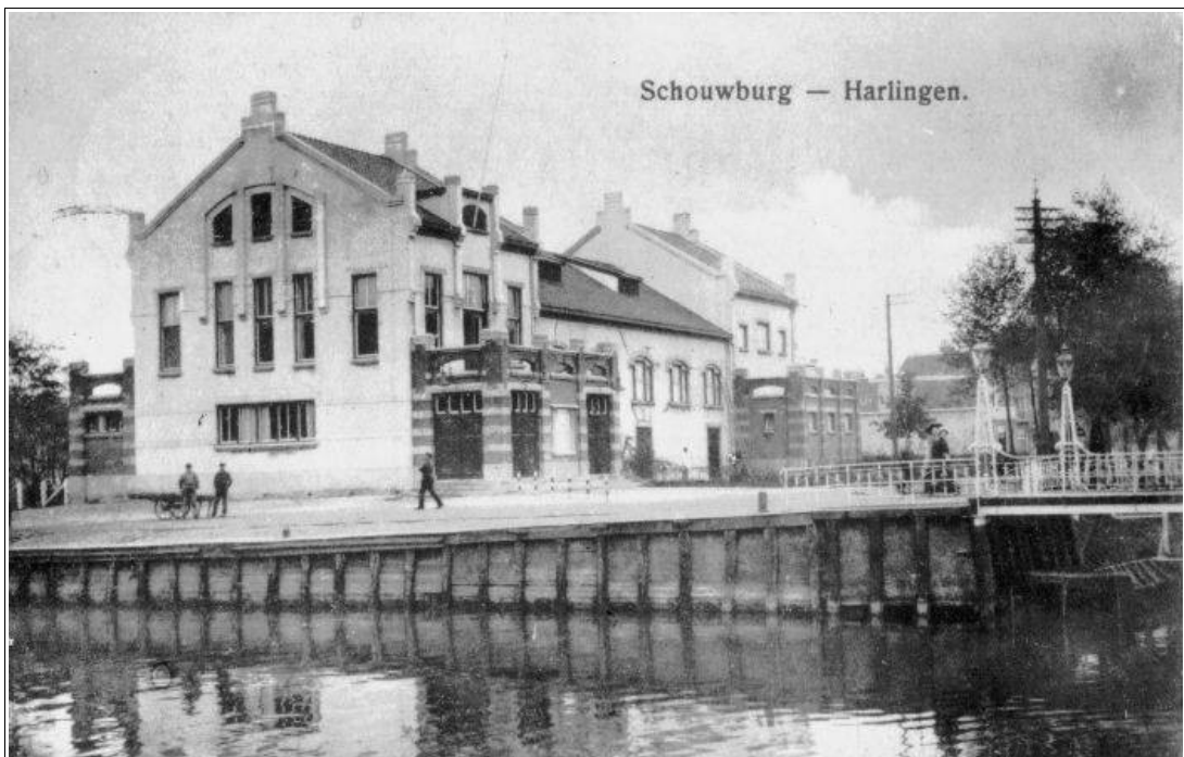
Figuur 11: Harlingen, Zuidoostersingel 1: foto van de schouwburg uit 1912. De foto is genomen in zuidoostelijke richting.
