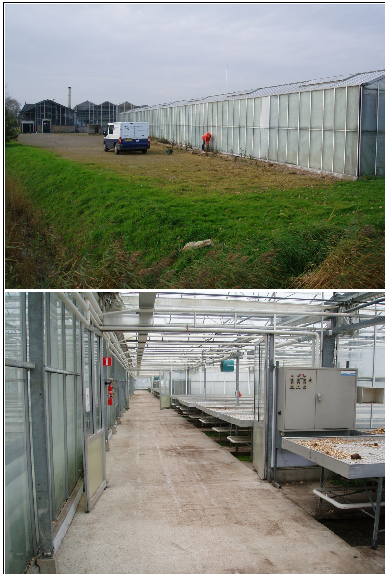
Figuur 2: Menaldum, Beetgumerdijk 15A: foto's van buiten en van binnen de kas. Op de bovenste foto wordt boring 2 uitgevoerd.
