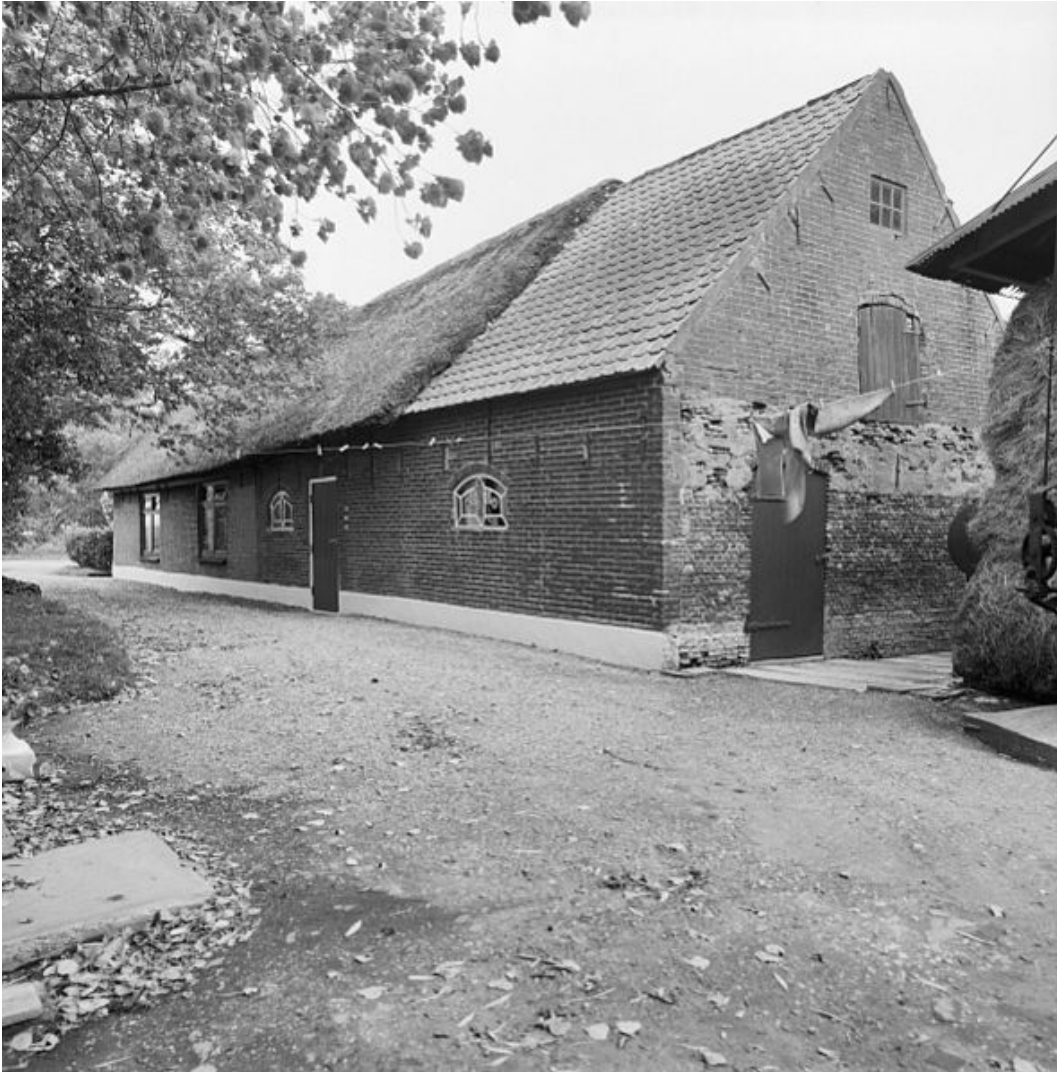
Afb. 6 Westelijke zijgevel van de boerderij. Let op de overgang tussen de metselwerken links van de deur. (Bron: beeldbank RCE).
