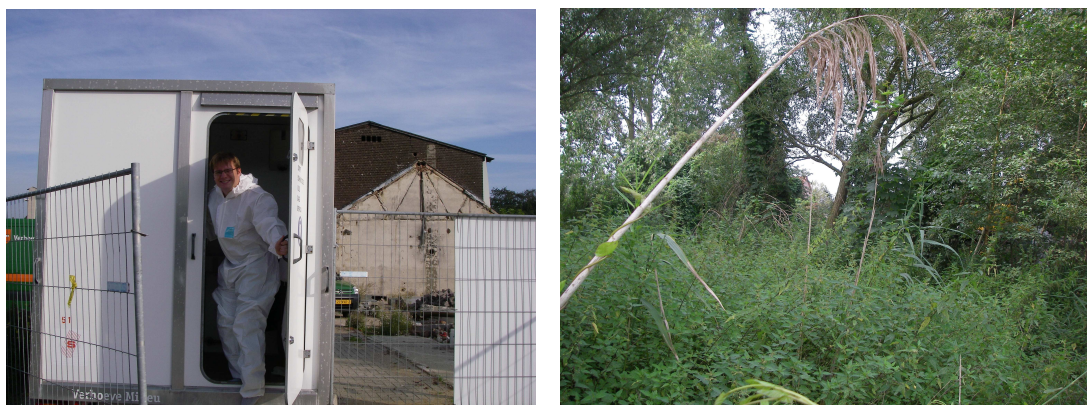
Fig. 3.1: Links: Beschermende kleding in verband met de aanwezigheid van asbest. Rechts de met brandnetels omgeven kolk.
