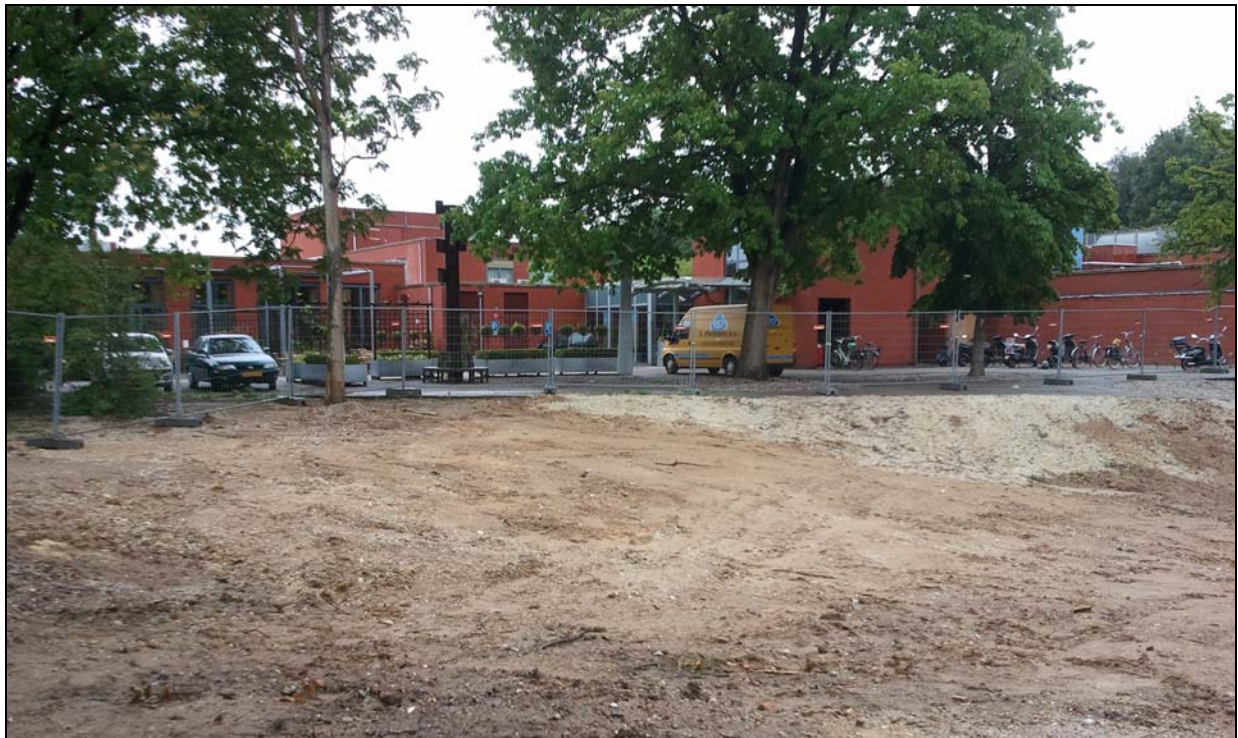
Figuur 17: Zicht op het bouwterrein met ontgraving vanaf boorpunt twee in noordoostelijke richting.
