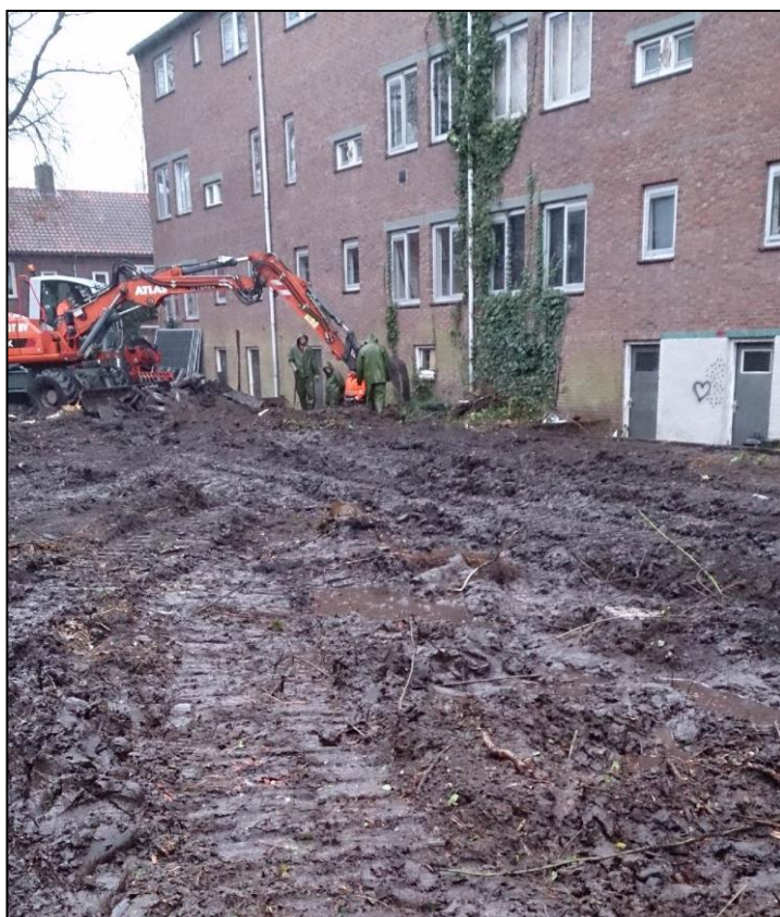
Figuur 5: Het plangebied bij aanvang van de werkzaamheden na het verwijderen van het groen in zuidwestelijke richting tussen de Montessori- en Fröbelstraat.
