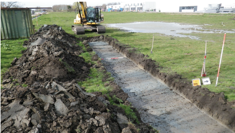
Afbeelding 3.2: foto van de werkzaamheden tijdens het onderzoek ter hoogte van werkput 3.
