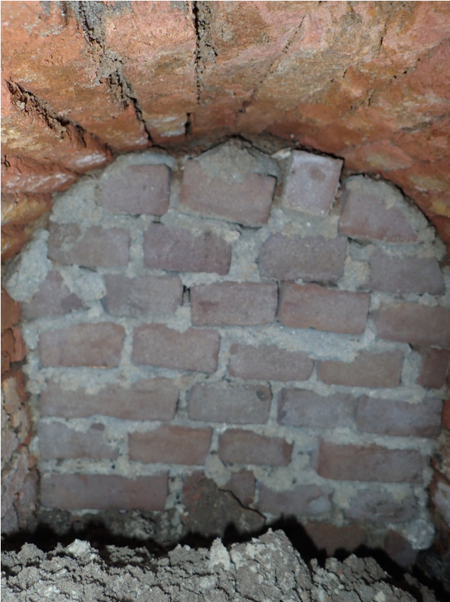
Afb. 3.17 Foto van de binnenkant van het intacte riool richting het noorden. Het riool is met moderne bakstenen dichtgemetseld.
