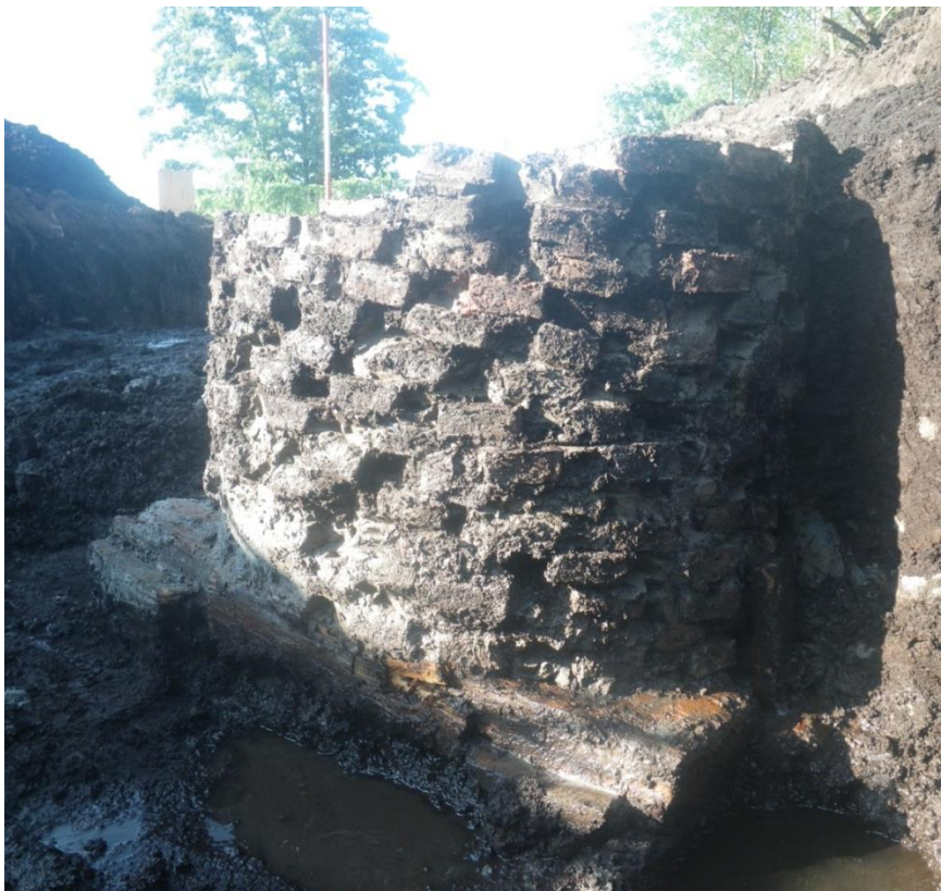
Figuur 15 Door het gewicht van de stenen opbouw is de waterput richting het westen verzakt.
