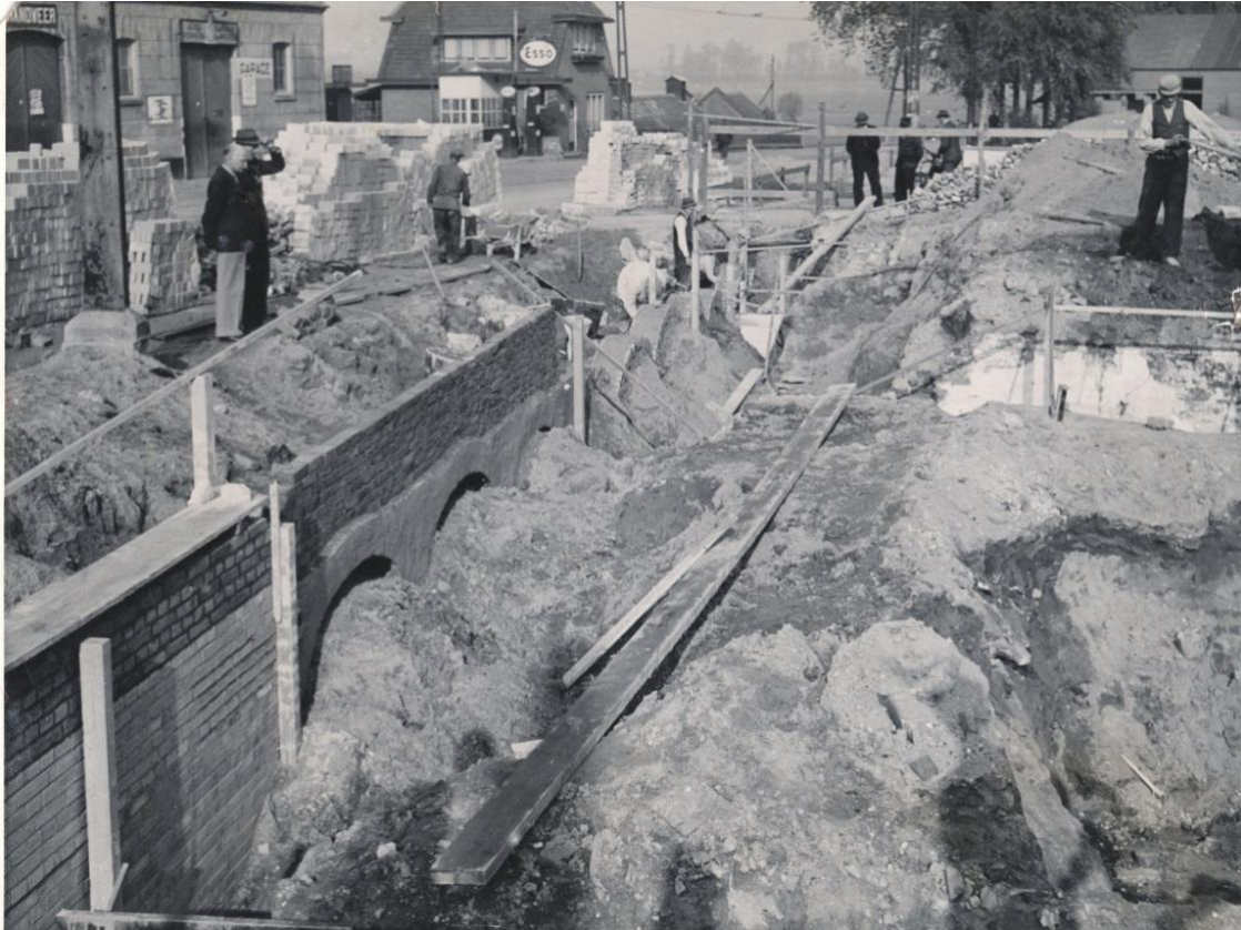
Afbeelding 17 Werk aan de Fred. van de Paltshof bij Garage De Rhoter in 1941. Let op de resten van oud muren rechts op de foto. Met dank aan dhr. Deys.
