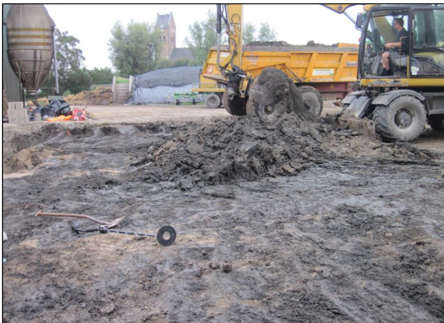
Afbeelding 8. Impressie van de werkzaamheden
