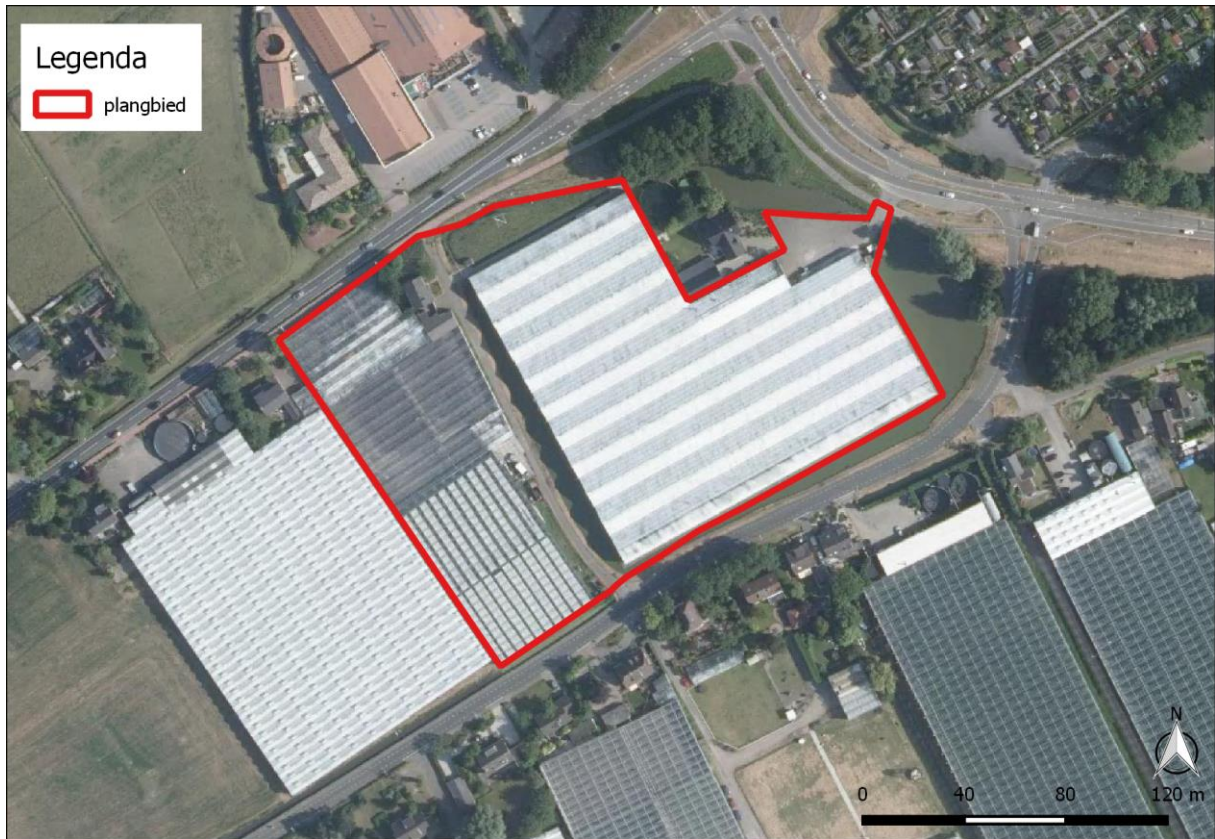
Figuur 2: Het plangebied (rood omlijnd) op een recente luchtfoto (bron: PDOK, Kadaster).
