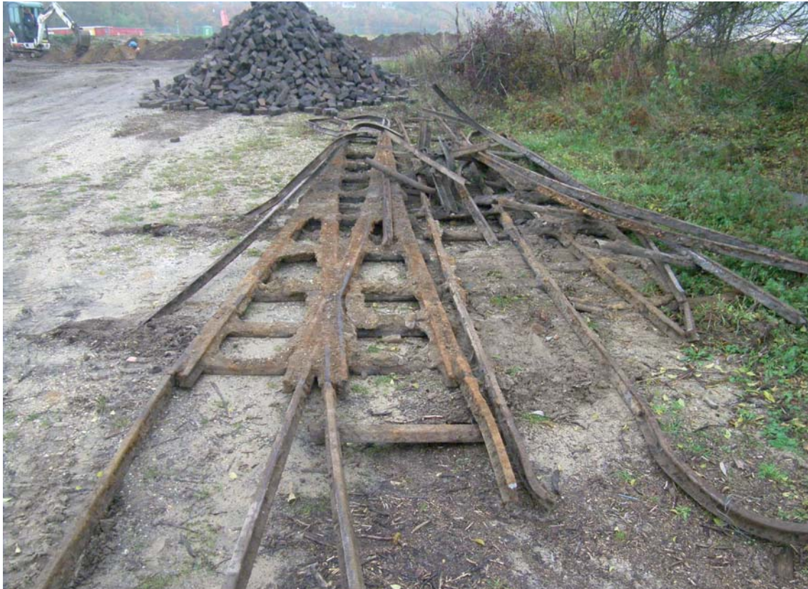
Figuur 3. Smalspoor -reeds verwijderd- in het westelijke deel van het plangebied.
