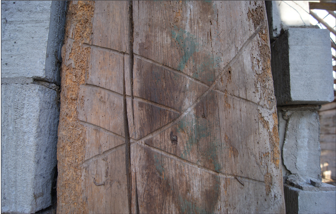
Afbeelding 9. Een groot merk op een vierkantstijl van de gesloopte stolpboerderij Kerkebuurt 196 in Berkhout.
