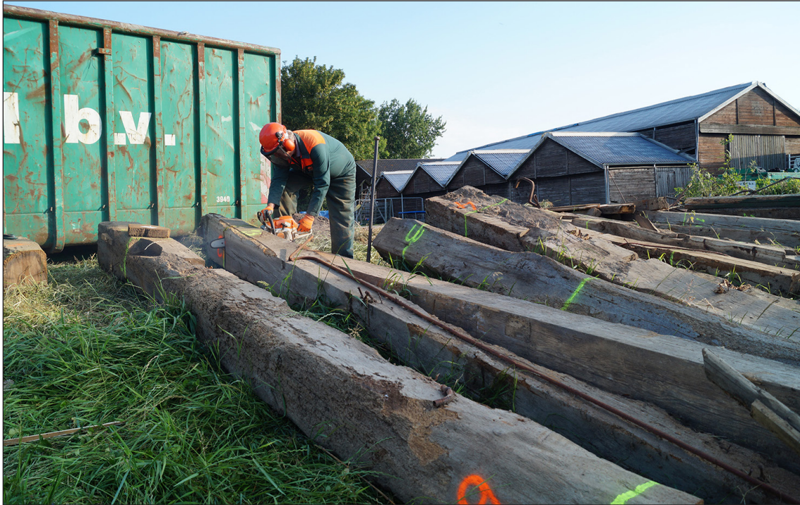
Afbeelding 10. Het zagen van elementen van een vierkant. Middelweg 25 in Opmeer.
