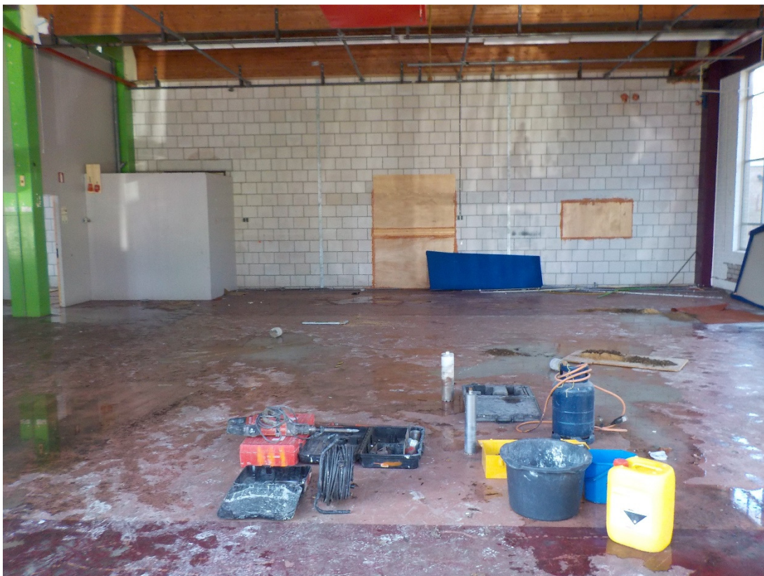
Afbeelding 6: Impressie van de meest noordelijk gelegen ruimte ten tijde van het verkennend booronderzoek. Aan de rechterzijde zijn in het midden en achteraan de locaties van respectievelijk boring 4 en boring 5 zichtbaar.
