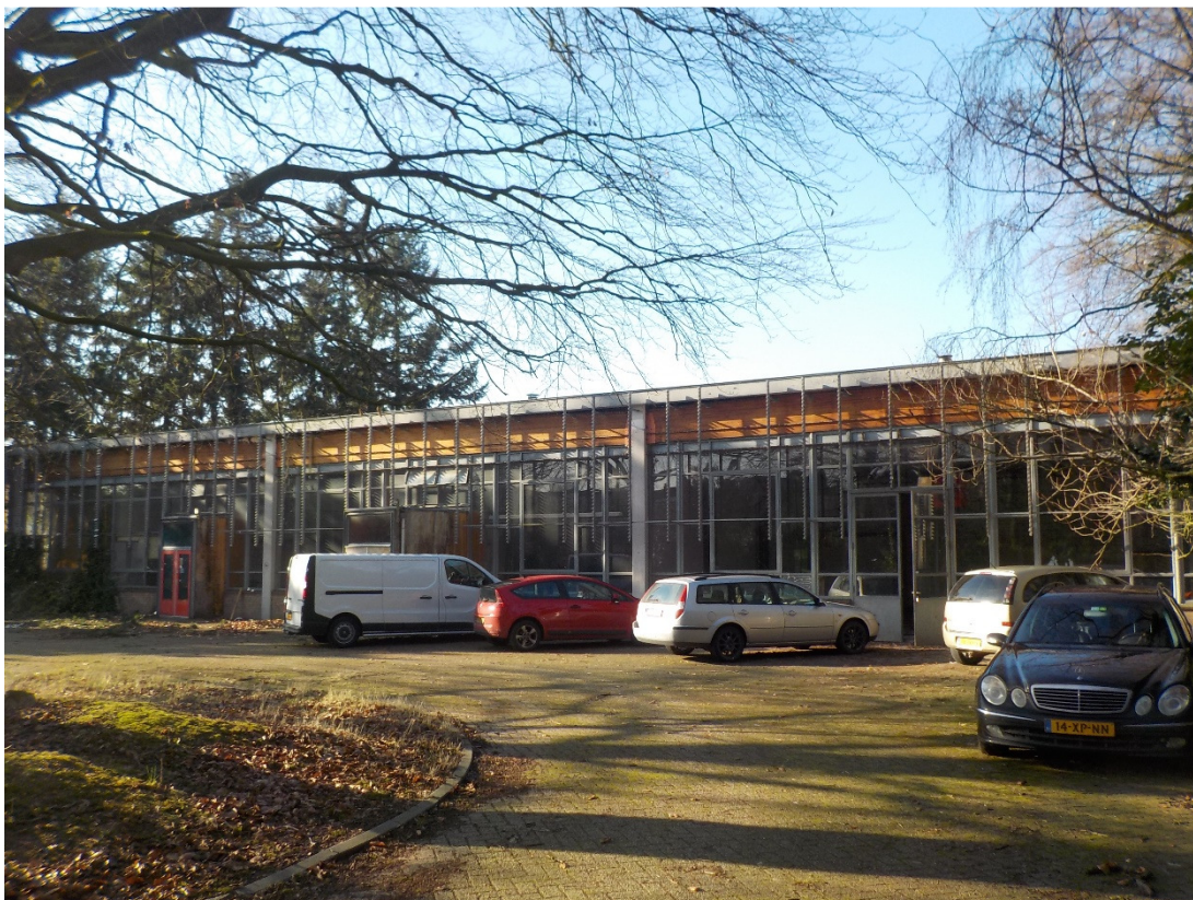
Afbeelding 5: Het plangebied (bestaand nog te slopen bedrijfspand) gezien vanaf de buitenzijde. De foto is genomen in westelijk richting.
