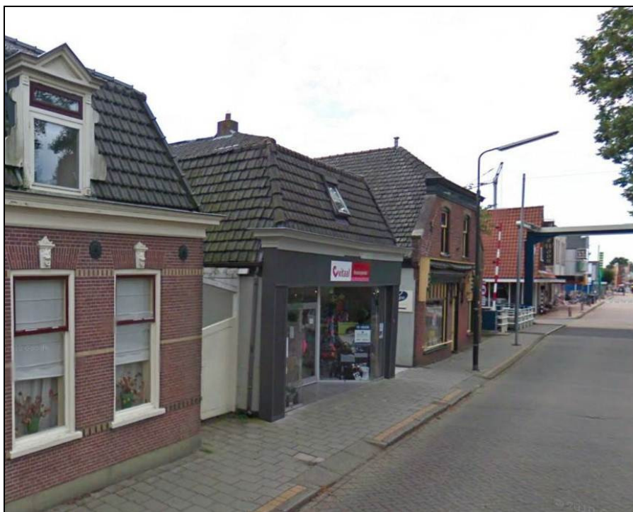
Hofland 8 (links), Hofland 6 en Hofland 2 voorafgaand aan de sloop van Hofland 6, gezien richting het zuiden.
