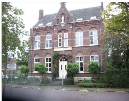
Figuur 2.7 Overzicht van het voormalige Sint Jozef Klooster (07-09-2011) aan de weg Op de Kemp. Het overgebleven gebouw uit 1902-1903 is een rijksmonument en heeft een half ingegraven kelder.
