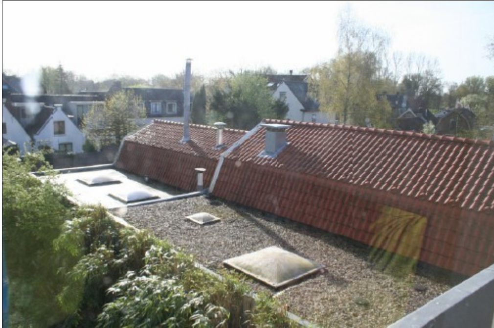
Afbeelding 4: Huidige situatie vanaf het naastgelegen pand, uitkijkend op het dak van het bedrijfspand bij nr. 22. (Bron: VVKH Architecten)
