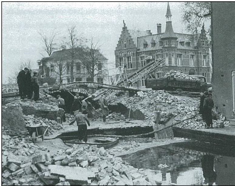
Fig. 9 De demping van de Oude Rijn, genomen vanaf het oosten richting de Haven (bron: RHC Rijnstreek).
