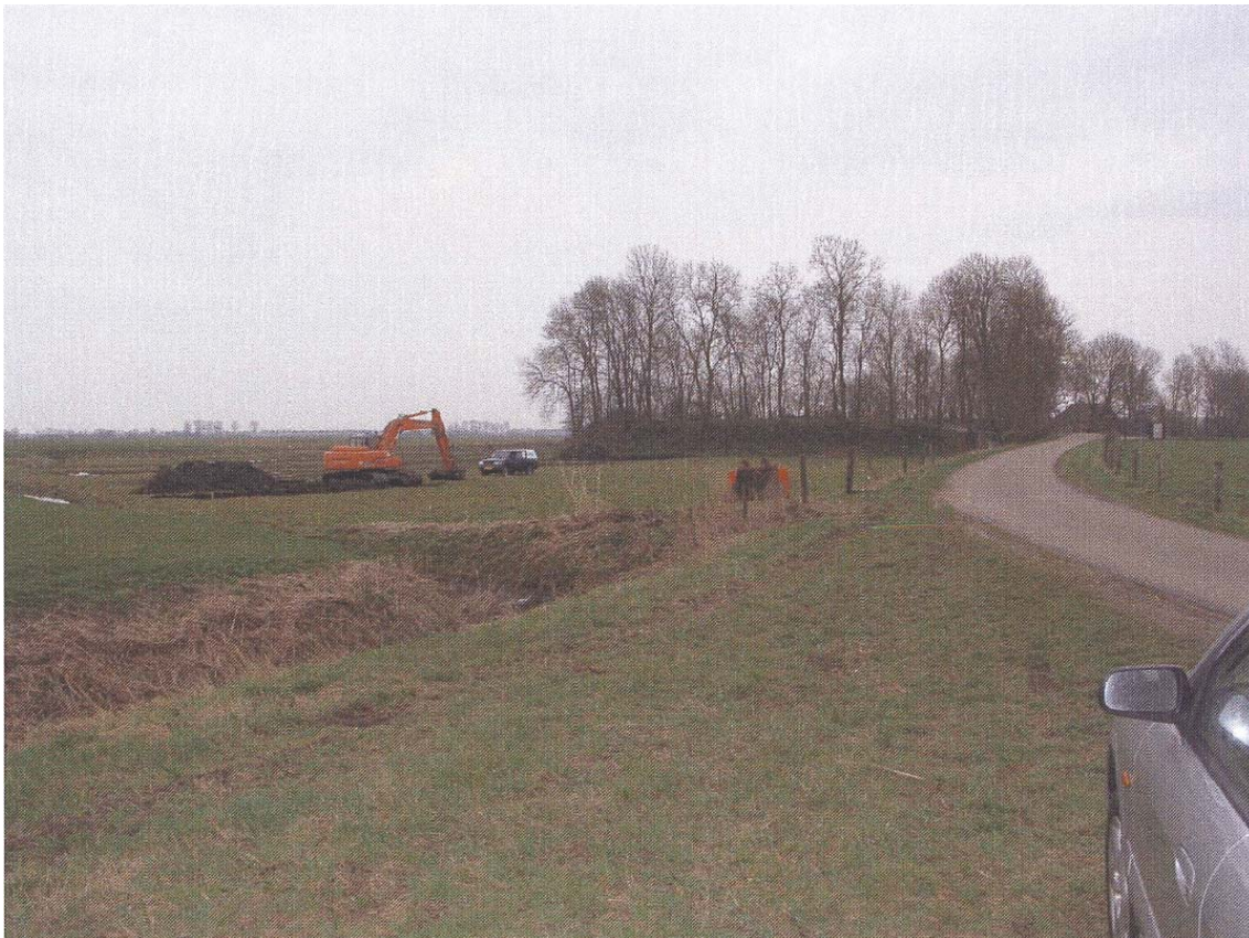
Afbeelding 1.1 : Overzicht over de Wierde Wierum, gezien vanuit het noorden, met de kern van het terprestant in midden van het beeld en rechts de Paddepoelsterweg (Foto: Grontmij)
