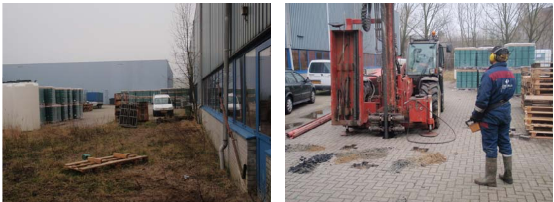
Figuur 3.1 Linker foto: het onverharde, zuidelijke deel van het plangebied ter hoogte van boorlocatie 2; kijkrichting noord. Aan de rechterzijde is een deel van een loods van House & Garden zichtbaar, die de oostgrens van het plangebied vormt. Rechter foto: het verharde, noordelijke deel van het plangebied ter hoogte van boorlocatie2; kijkrichting zuid met de mechanische boormachine in actie. Op een viertal plaatsen zijn de klinkers verwijderd met een onderlinge afstand van circa 0,5 m.
