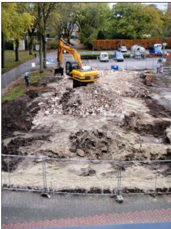
Afbeelding 4. Beeld van de sloop van de funderingen. Het zandbed is goed te zien en de grond uit de schuurtjes ligt vooraan.
