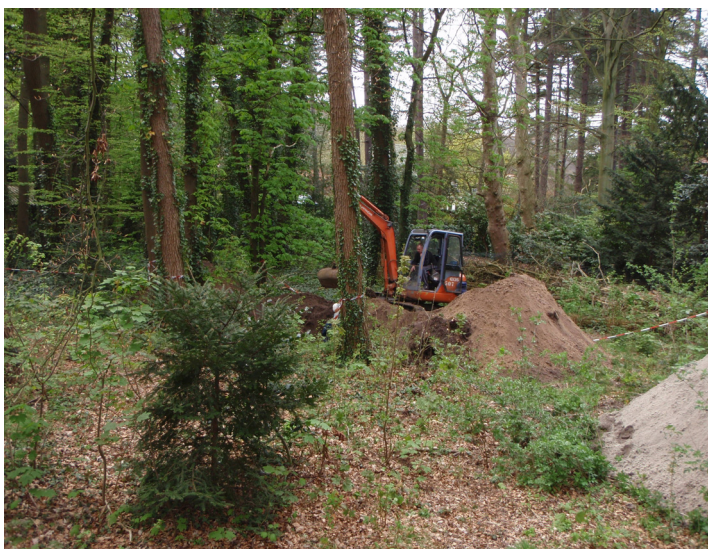
Afb. 3: Het graven van de proefputten tussen de bomen met een 'mini-graver'.
