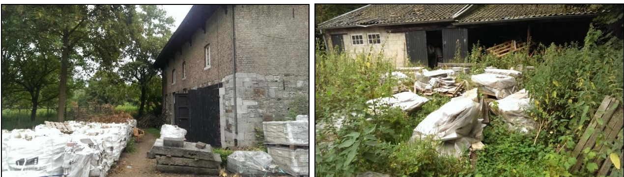
Figuur 9a en b Zicht op het plangebied rond de schuur. Links (a) het terrein aan de westzijde van de hoeve (schuur), gezien naar het noorden en rechts (b) de oostkant gezien naar het zuidwesten. Op de pallets staan ingepakte bouwmaterialen, zoals natuurstenen bouwelementen, bakstenen (veldbrand) en tegels.
