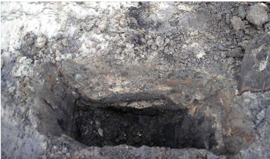
Figuur 1. Doorsnede door keienverharding
