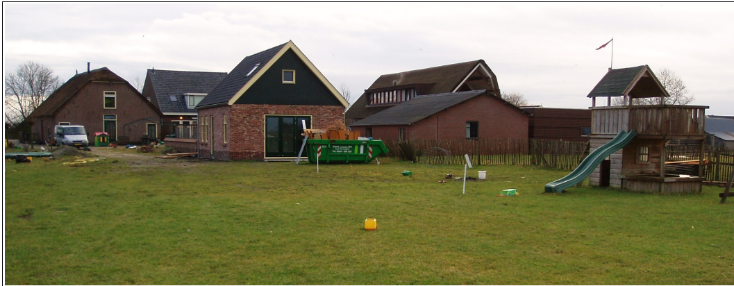
Figuur 2: IJsselstein, Achtersloot 89A: foto genomen in oostelijke richting. Het zwembad is gepland tussen de groene afvalcontainer en het houten klimtoestel. Uiterst links op de foto staat het woonhuis.
