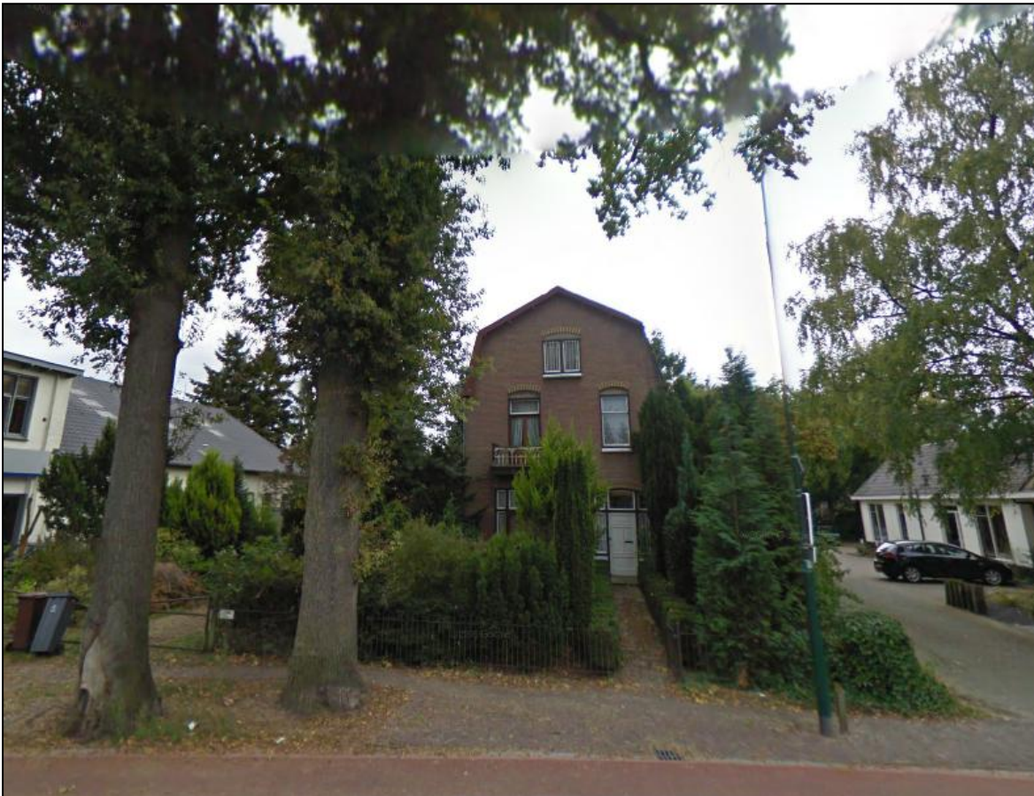
Figuur 1: Dorpsstraat 28 vóór de sloop.
